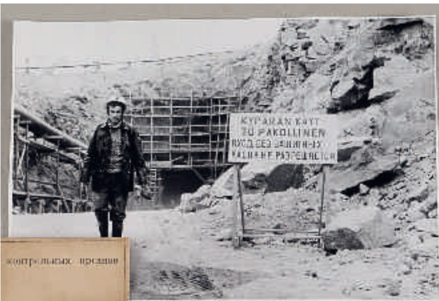
Rakentaja ajotunnelin suulla. Tiukka turvallisuuskuri piti vaikeat työtapaturmat minimissä.
